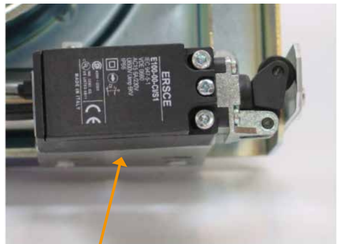
Mikrobrytare monterad på spjäll.
