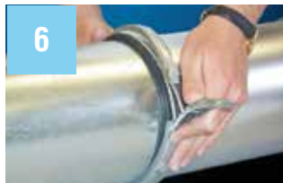
6 Lås fast QF spännbandet över O-ringen och ena änden av skarvröret.
