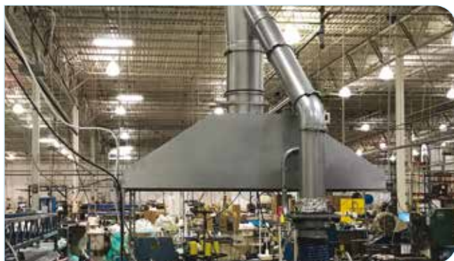
Exemplo de uma transformação de retangular a redonda
