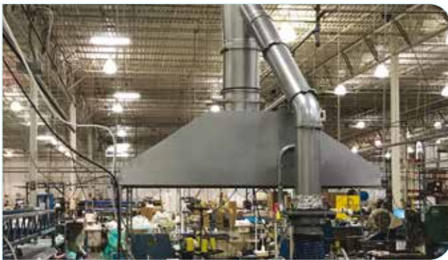
Eksempel på overgang fra rektangulær til rund
