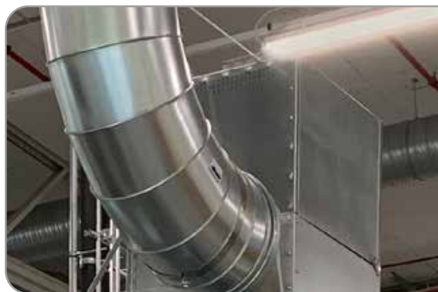
Quick-Fit-segmentbøjninger muliggør ændring af luftstrømmens retning i et rør.
