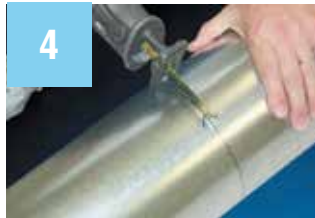
4 Rohr abschneiden.
