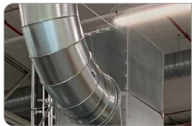
Quick-Fit Segmentbögen ermöglichen eine Richtungsänderung des Luftstroms in einem Kanalverlauf.
