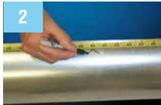
2 Rohrlänge abzüglich 100 mm an zeichnen.
