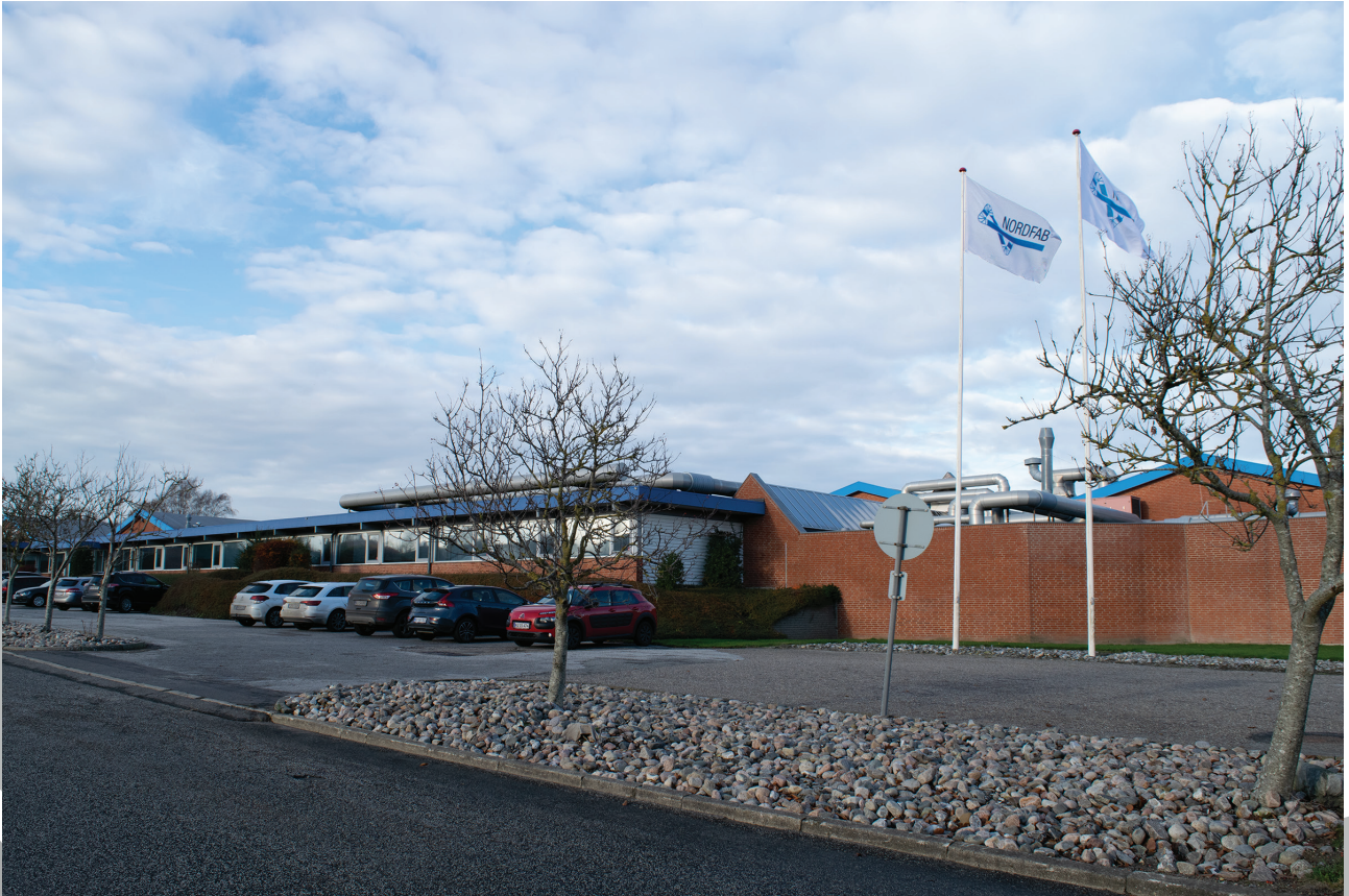
Ventes et production Nordfab Europe A/S à Assen Mariager, Danemark.
