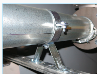
Conduit monté avec collier de support conduit and jambes pour support conduit.
